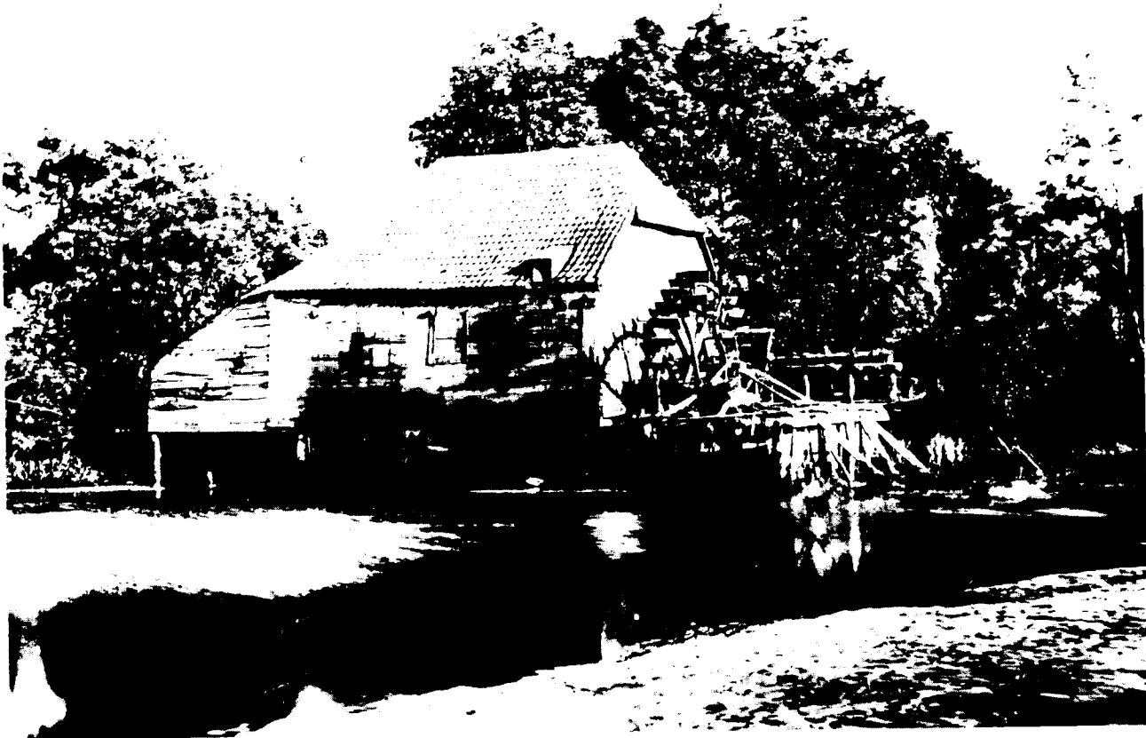
44. De Graan- en Schorsmolen van Venbergen met zijn twee raderen in 1902. Twee paar stenen maalden het graan, één paar de schors voor de leerlooiers. Ze konden gelijktijdig werken.*
